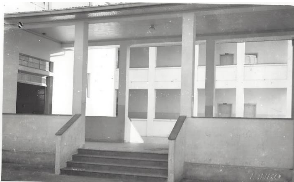
Corredor interno do prédio.
