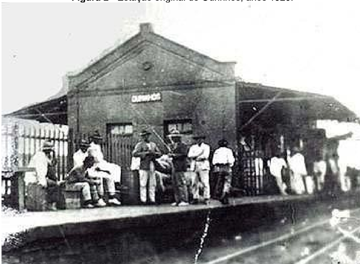
Figura 2 - Estação original de Ourinhos, anos 1920.
