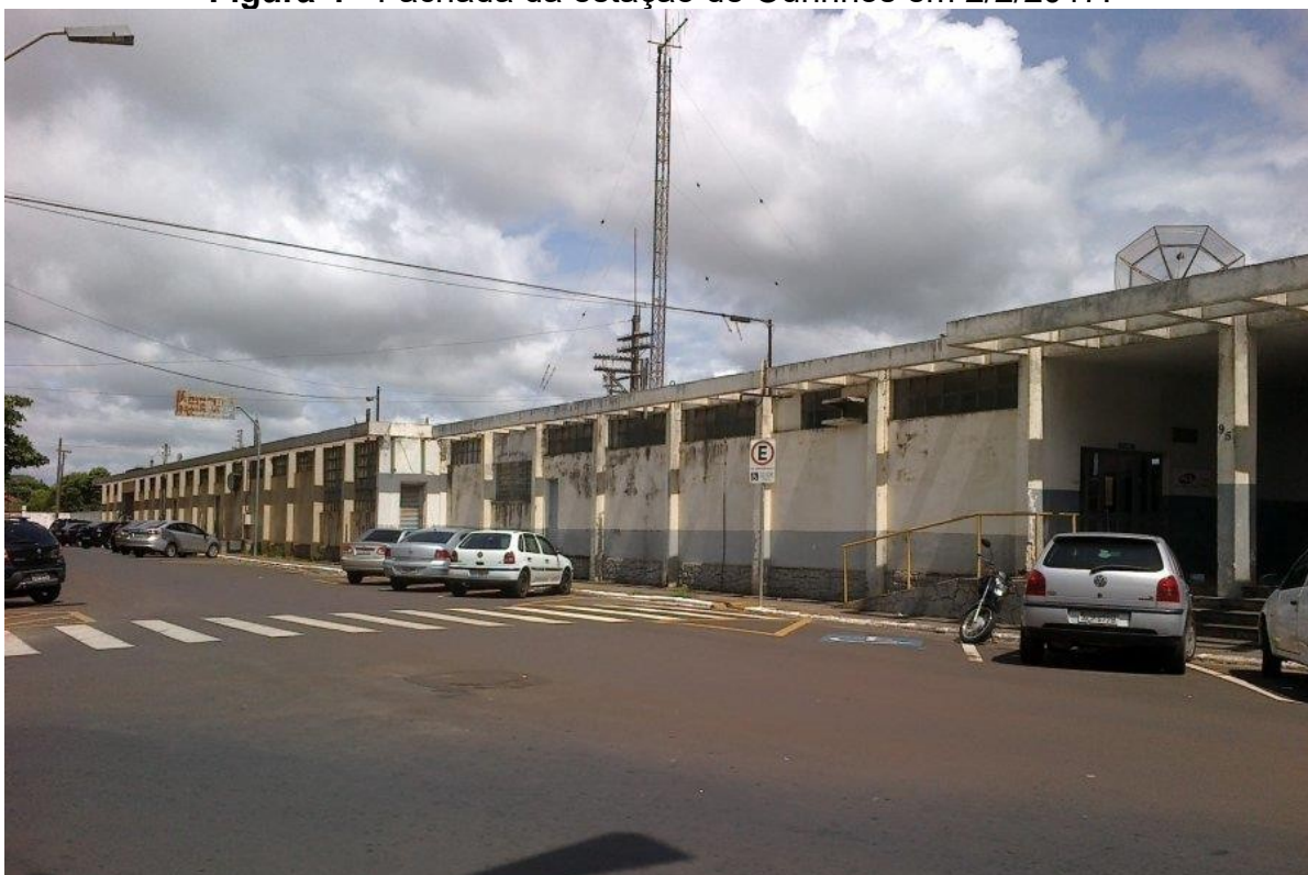
Figura 4 - Fachada da estação de Ourinhos em 2/2/2017.
