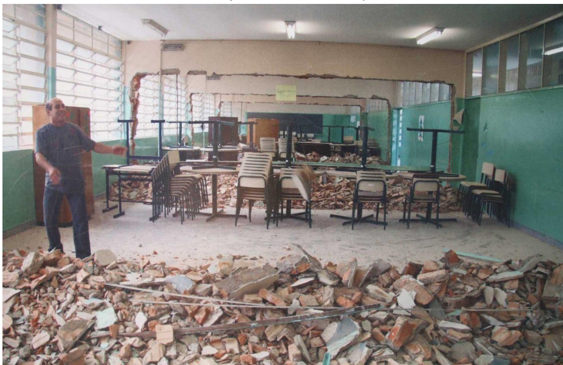
IMAGEM 24 - O diretor Braz ajuda a derrubar as paredes das salas de aula.
