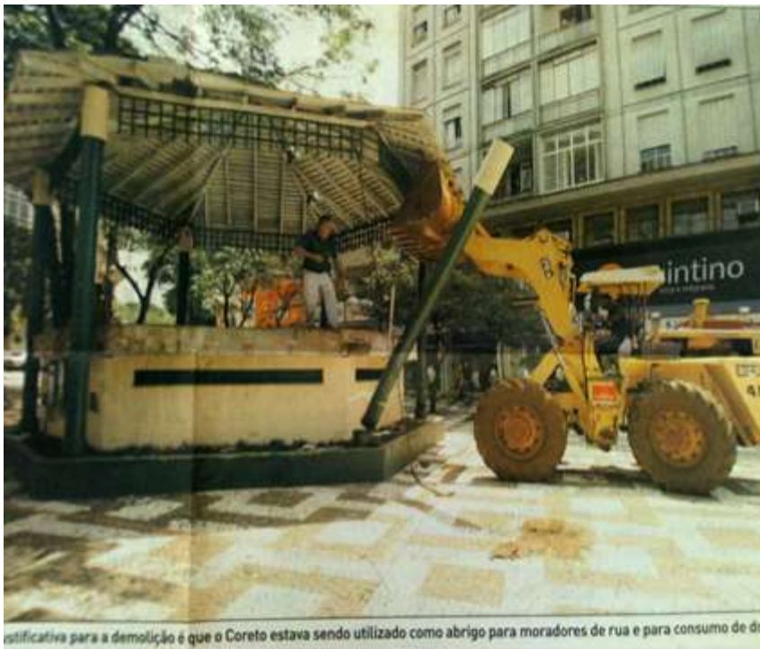
Figura 34 – Coreto no Calçadão sendo demolido
